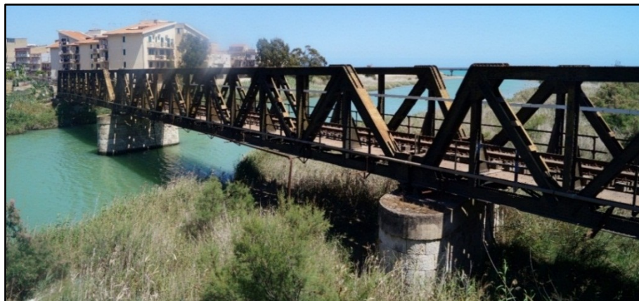
Figura 3 Ponte a travate metalliche sul fiume Salso
