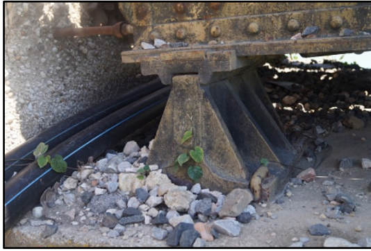
Figura 1 Appoggio cerniera
