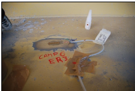
Figura 10 Incollaggio ER sull'acciaio
