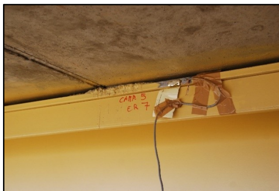
Figura 12 Incollaggio ER sulla piattabanda inferiore
