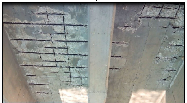
Figura 4 – Traverso di bordo e soletta. Espulsione del copriferro e corrosione delle armature.
