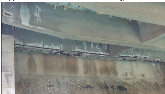
Figura 4 – Traverso di bordo e soletta. Espulsione del copriferro e corrosione delle armature.
