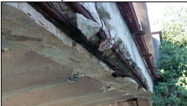
Figura 3 – Trave di bordo. Degrado delle armature e distacco del copriferro.
