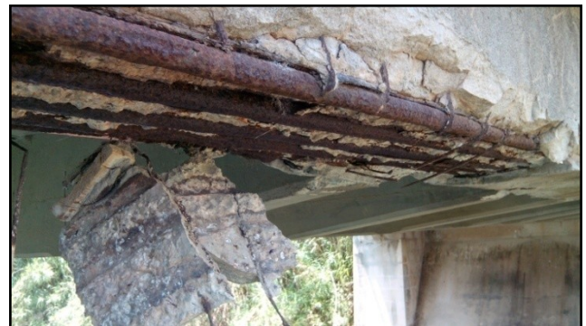
Figura 3 – Trave di bordo. Degrado delle armature e distacco del copriferro.
