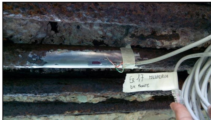
Figura 12 – Preparazione della superficie.
