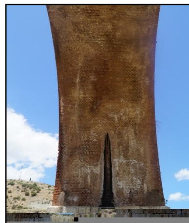
Figura 5 Disgregazione giunti di malta e degrado in corrispondenza del doccione
