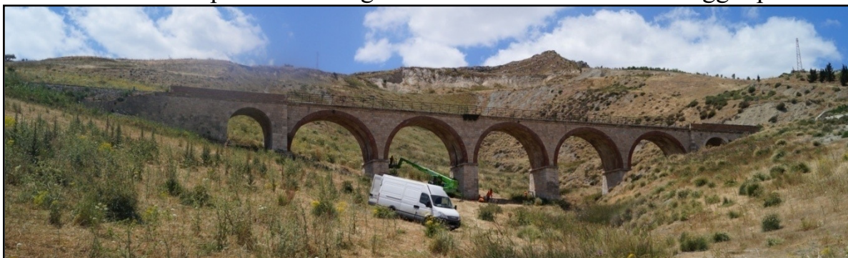
Figura 1 Vista frontale del viadotto
