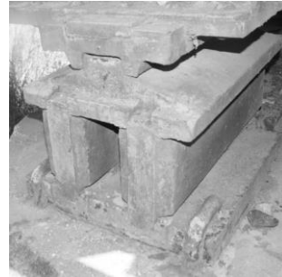
Fig. 10. Particolare appoggio carrello
