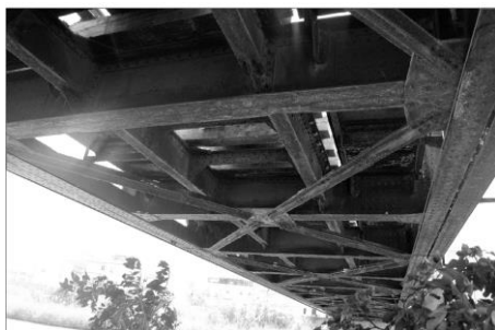
Fig. 4. Vista travi di bordo
