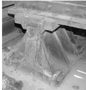
Fig. 9. Particolare appoggio cerniera
