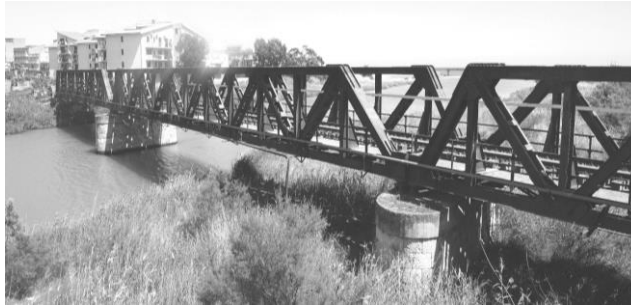
Fig. 1. Veduta d'insieme del ponte sul fiume Salso
