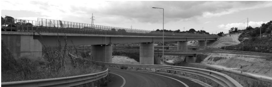
Fig. 1. Veduta d'insieme del Viadotto Molona
