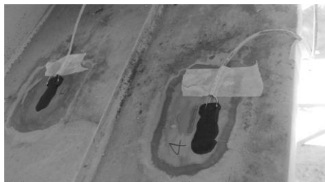
Fig. 8. Applicazione strati di protettivo sugli ER installati su acciaio
