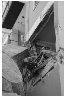
Fig. 3. Trave 51-52 impalcato piano ammezzato
