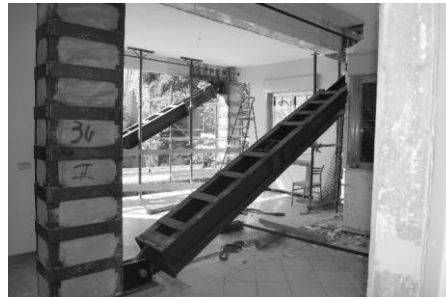
Fig. 12. Vista puntoni telescopici primo e secondo telaio
