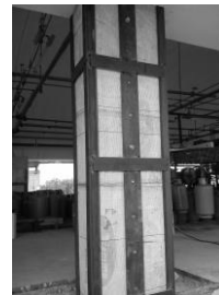
Fig. 10 Rinforzo pilastri centrali
