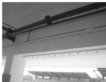
Fig. 14 Intervento su trave perimetrale
