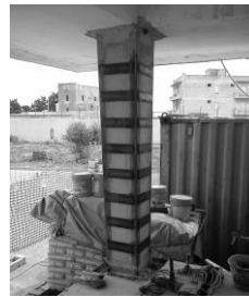
Fig. 8 Esempio rinforzo pilastro perimetrale
