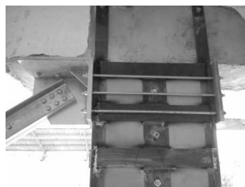
Fig. 12 Fissaggio alla testa del pilastro
