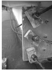
Fig. 16 Installazione trefoli
