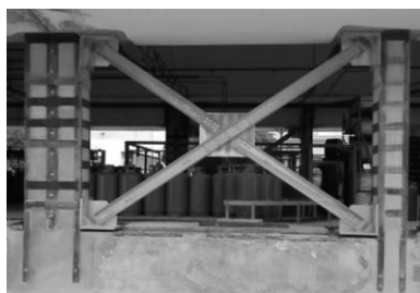
Fig. 11 Vista frontale controvento parete
