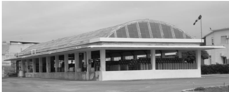
Fig. 1 Vista d'insieme del capannone di imbottigliamento
