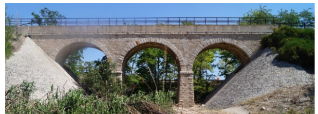
Figura 1. Vista frontale del ponte a tre arcate
