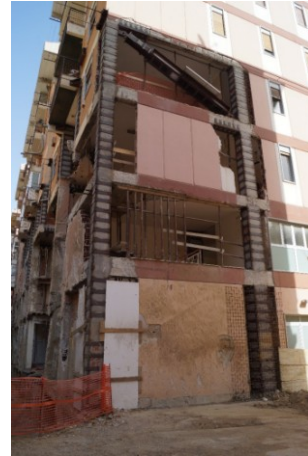
Figura 11. Vista della pilastrata d'angolo dopo l'intervento
