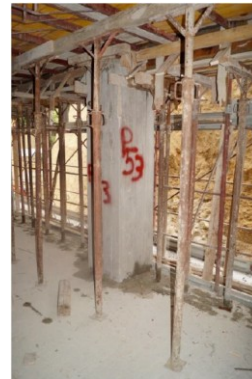
Figura 15. Vista pilastro 53 dopo la ricostruzione
