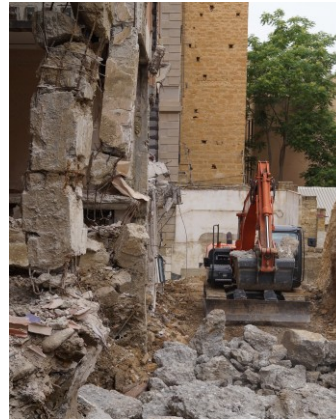
Figura 2. Prospetto Nord dopo la rimozione delle macerie
