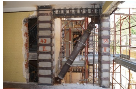
Figura 9. Vista dell'intervento di incamiciatura su travi e pilastri
