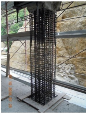
Figura 14. Vista pilastro 53 durante la ricostruzione
