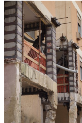
Figura 7. Vista dei pilastri incamiciati-piano secondo
