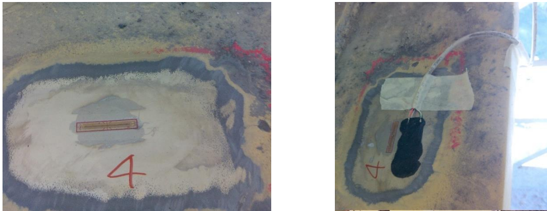
Figura 8. Preparazione della superficie e applicazione degli strati di protettivo
