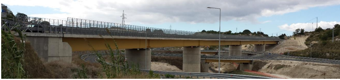
Figura 1. Vista d'insieme del manufatto.
