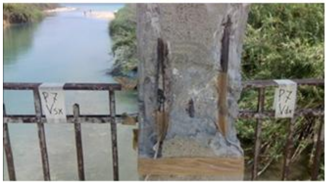
Figure 10. [1] Preparation of the steel surface and strain gauge bonding/ Preparazione della superficie di acciaio ed incollaggio dell'ER. [2] Application of protective layers/ Applicazione degli strati di protettivo
