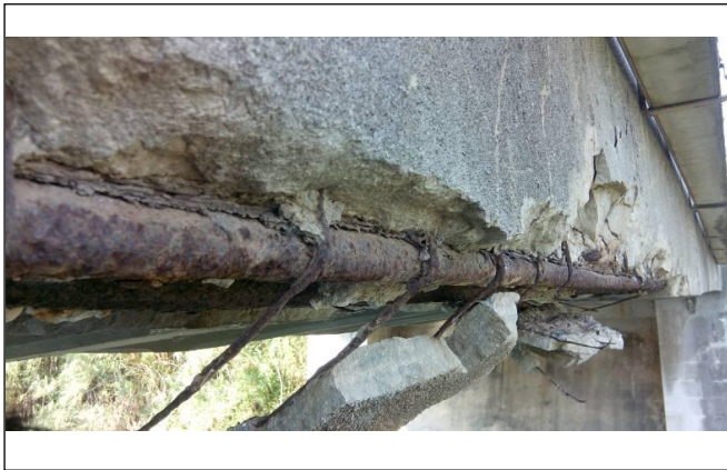
Figure 9. Bar state before preparation/Stato della barra prima della preparazione
