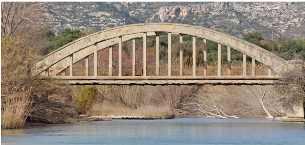
Fig. 11 Ponte sul Fiume Cassibile
