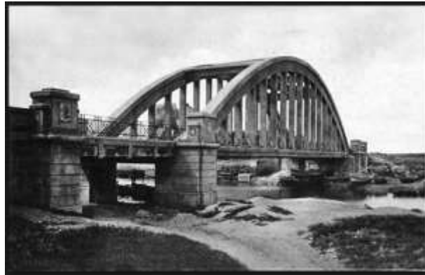
Fig. 1 - Ponte sul fiume Mazzaro – Mazara del Vallo
