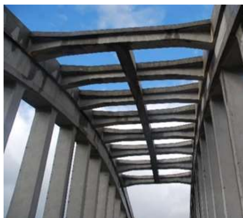
Fig. 2 - Ponte sul Fiume Belice - SP 22 - Particolare controventi
