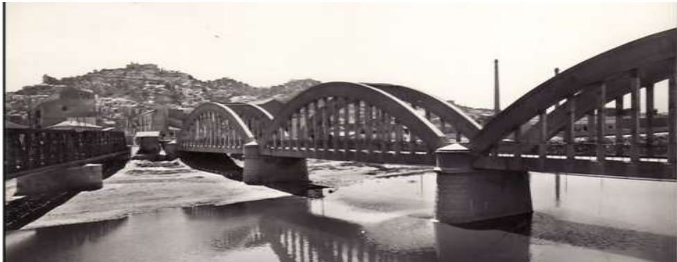
Fig. 12 - Ponte sul fiume Salso - Licata
