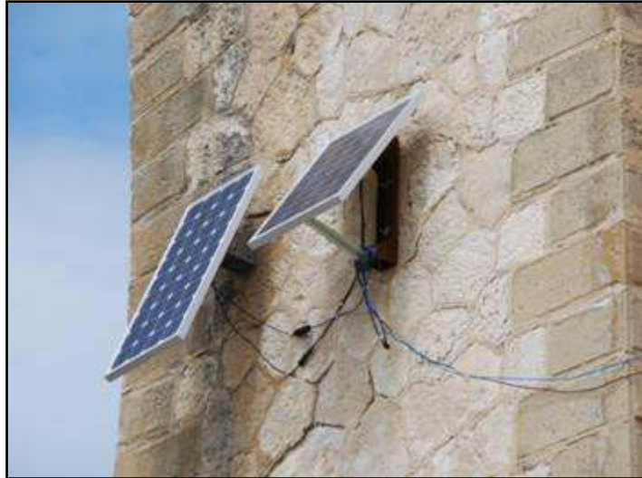
Figura 5: Installazione del sistema di alimentazione elettrica autonomo
