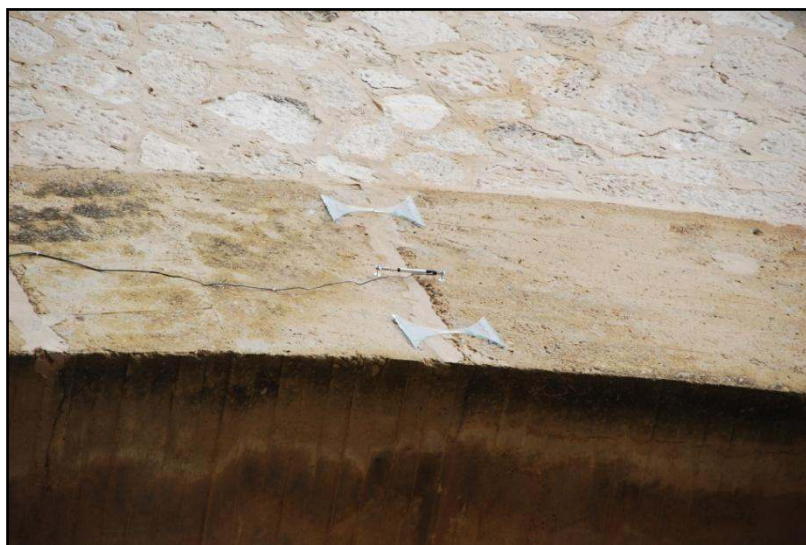
Figura 3-Biffe installante durante un precedente monitoraggio
