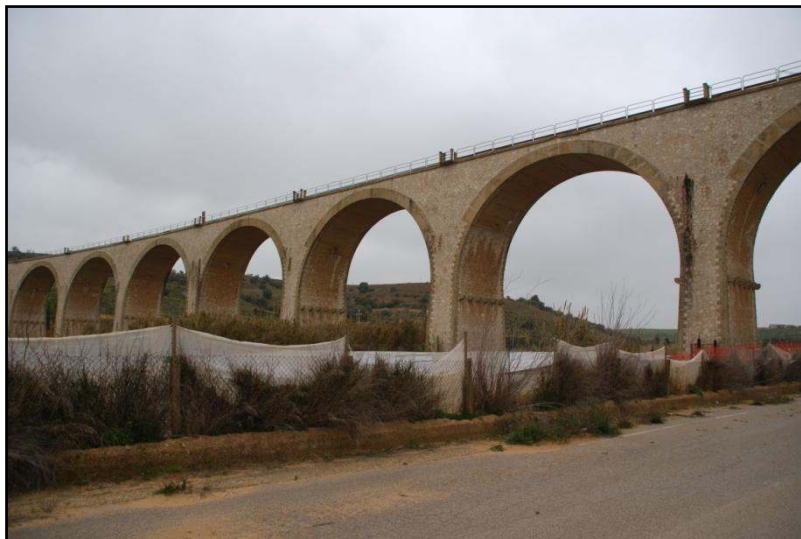
Figura 2- Vista d'insieme del Viadotto oggetto del monitoraggio
