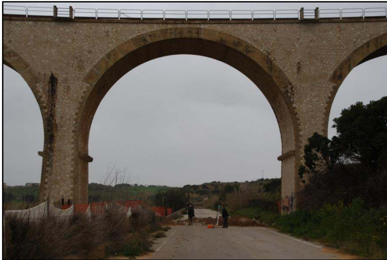
Figura 1: Volta sottoposta a monitoraggio
