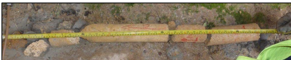
Figura 4 – Carota prelevata dalla spalla.
